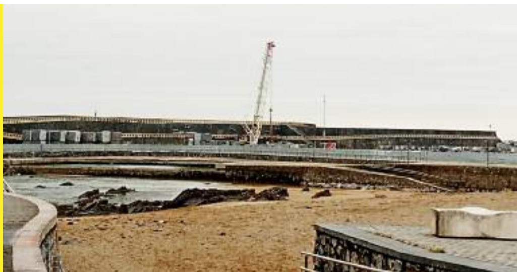
Mutrikuko babes dikeko obrak.
